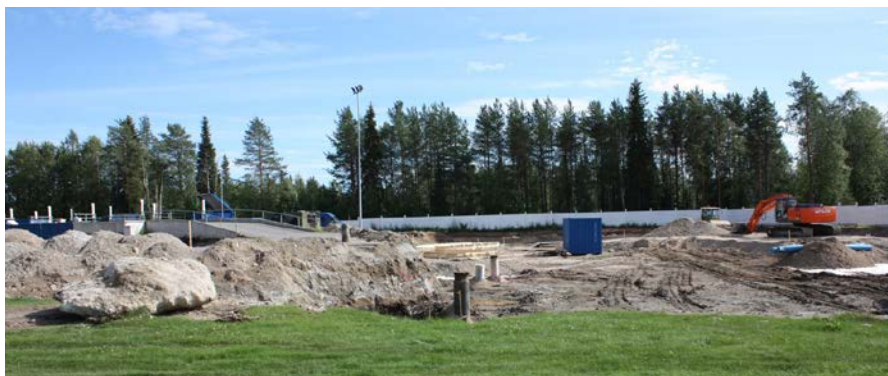
Alakorkalon jäteasemalle tehtiin laajennustöitä ennen jätteenpolttoon siirtymistä vuonna 2015.
