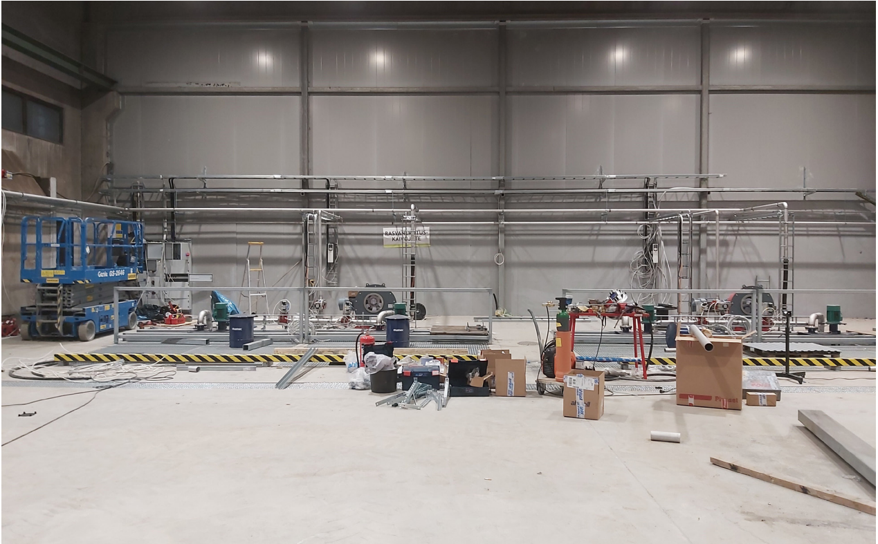
Uuden bioaseman rakentamista.
