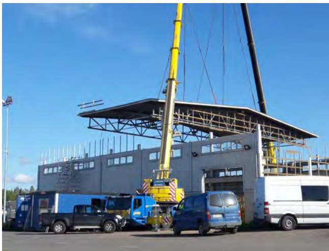
Kierrätyspuisto Residuumissa sijaitsevan hallin kattoa koroitettiin kesällä 2018.
