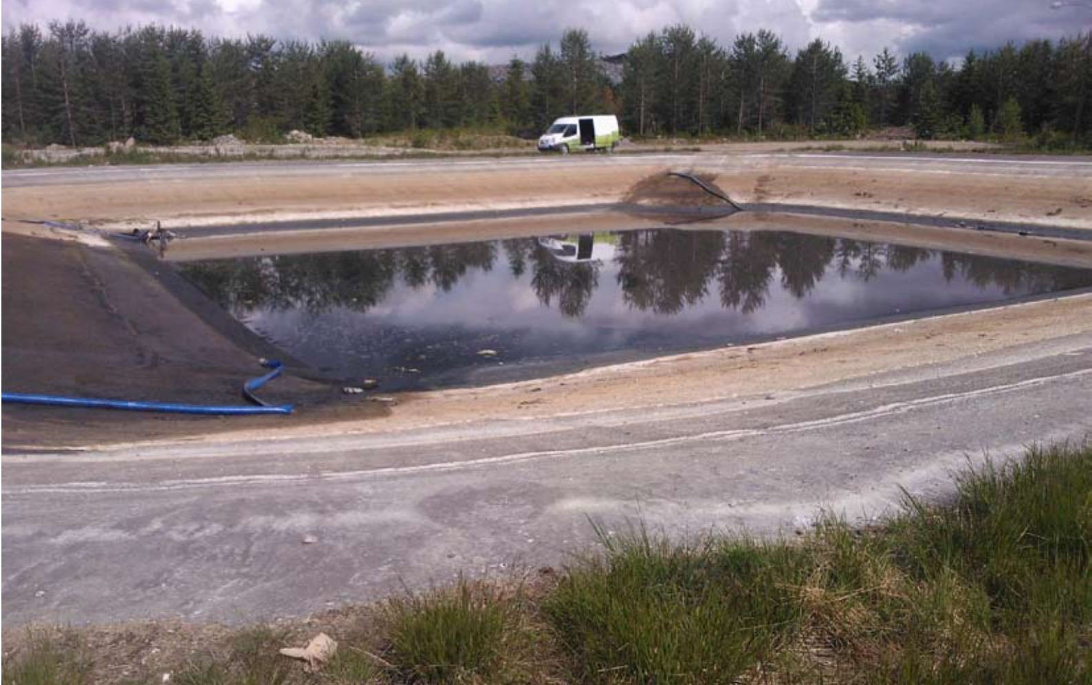
Kuusiselän kaatopaikan tasausaltaat puhdistettiin kesällä 2013.
