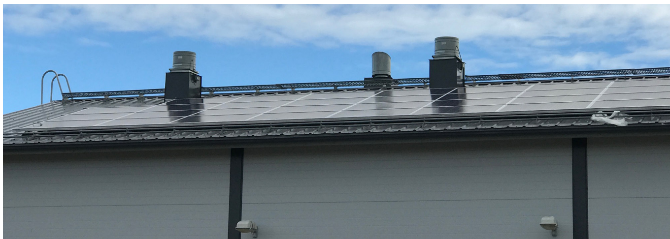
Kuusiselän kaatopaikan huoltohallin katolle asennetut 38 aurinkopaneelia lisäävät alueen energiaomavaraisuutta.
