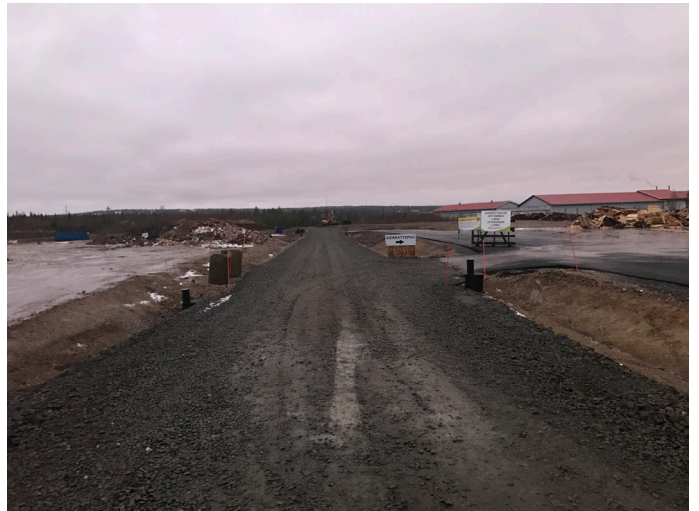
Alakorkalon jäteaseman uuden hyötykäyttöalueen teiden ja alueiden rakentamisessa hyödynnettiin murskattua betonia noin 6 550 tonnia.
