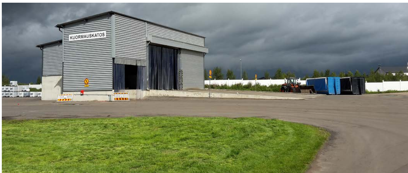
Alakorkalon jäteaseman kuormauskatokseen asennettiin suikaleovet 4.8.2016.
