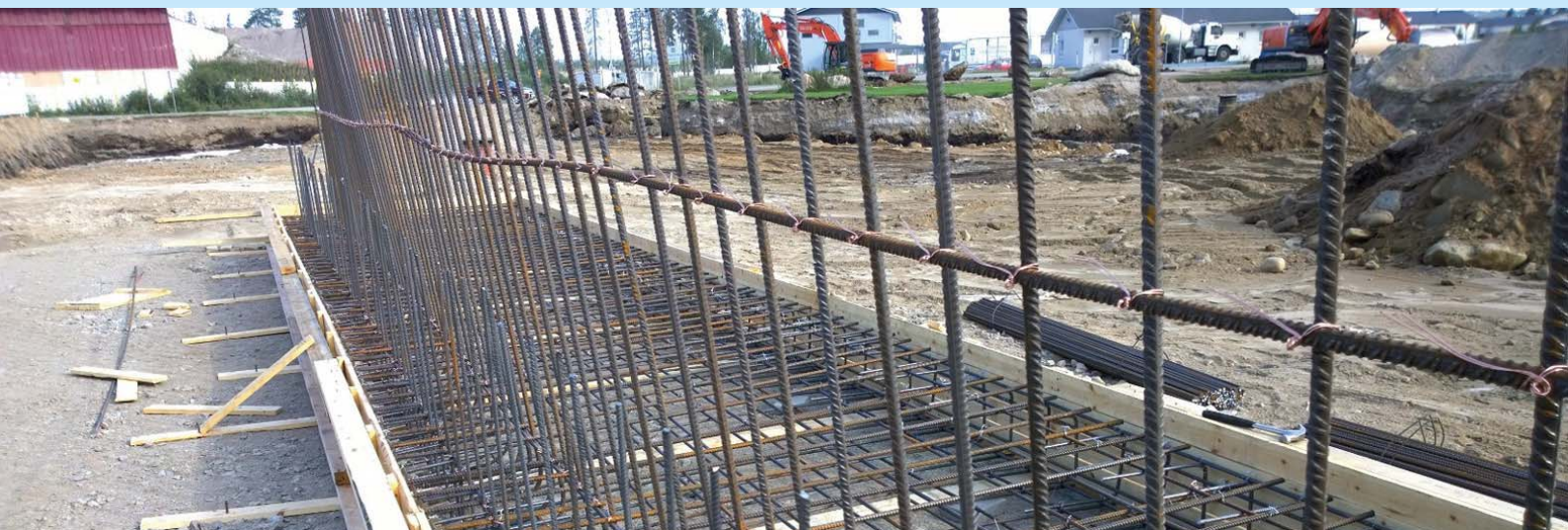
Alakorkalon jäteasemalle valmistui uusi hyötykäyttöön ohjattavien jätteiden, sähkölaitteiden ja vaarallisten jätteiden vastaanottoalue Ekokieppi. Kuva rakennusvaiheen alkutaipaleelta kesällä 2014.
